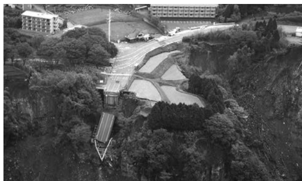
写真-3 寸断された阿蘇大橋
