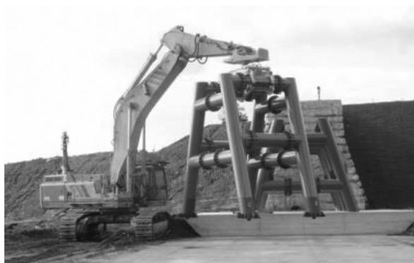
写真-2 無人化施工による鋼製スリット設置
