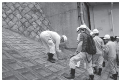
写真一2 現地での点検実習の状況
