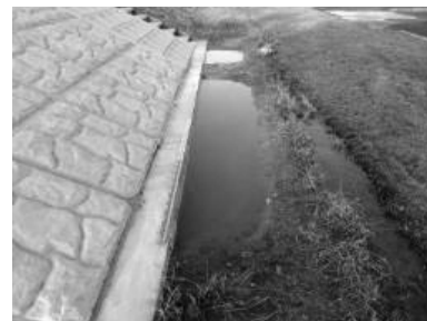
写真一 4 護岸基礎部前面に洗掘を追加
