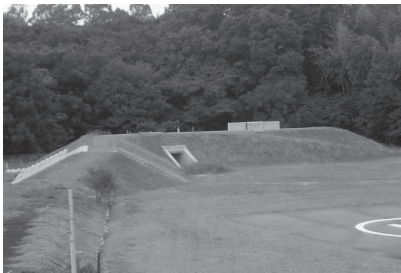
写真一3 研修用不具合堤防の全景 (H28.10.28撮影)
