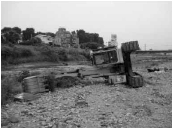
写真 2 重機の転倒事故
