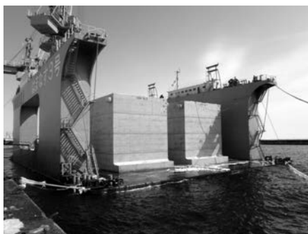
写真—1 FDによるケーソン製作（同時製作4函）
