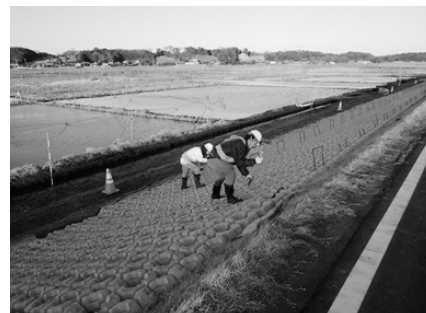
写真—5 アンカーピン打設状況
