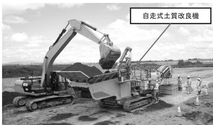
写真—2 自走式土質改良機による施工状況
