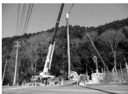
写真—8 鋼矢板吊り込み状況
