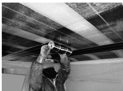
写真—6 炭素繊維シート接着状況
