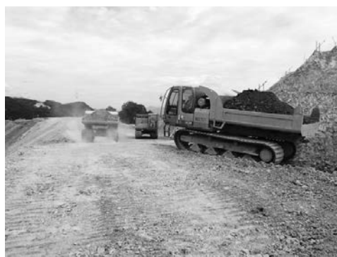
写真—1 土砂運搬作業状況
