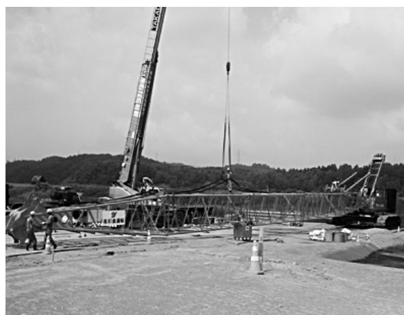
写真—15 クローラクレーン組立状況
