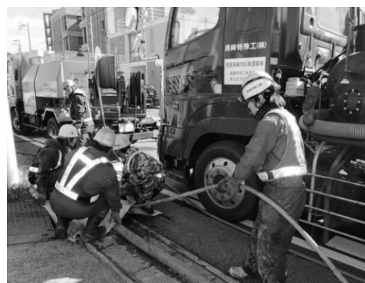
写真—13 側溝清掃作業状況
