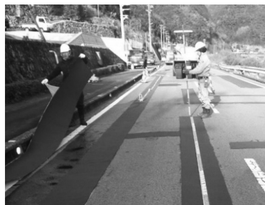
写真—11 クラック防止シート張り状況
