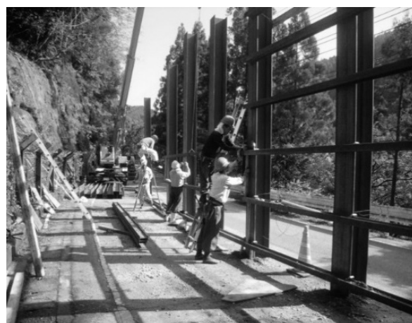
写真—17 防護柵設置状況
