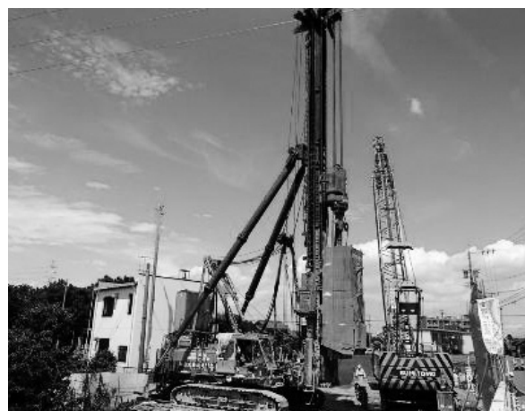
写真—16 杭打施工状況
