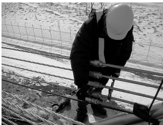
写真—19 ケーブル張り施工状況
