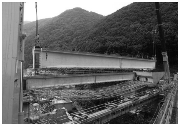
写真—20 主桁架設状況
