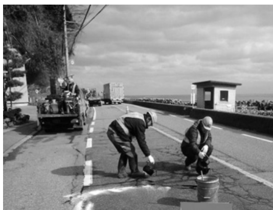
写真—10 注入剤注入状況
