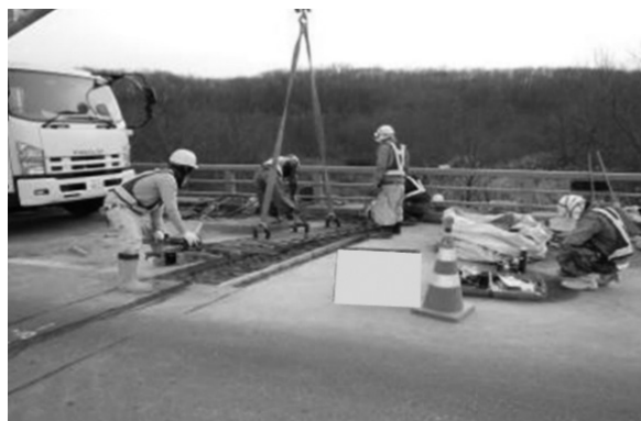
写真—21 伸縮装置据付状況
