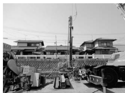
写真—9 鋼矢板圧入状況
