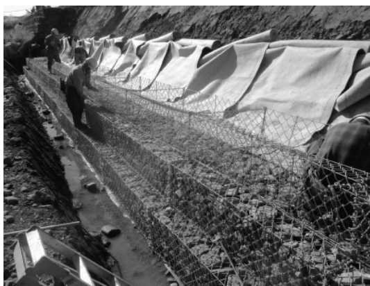
写真—3 かごマット組立・据付状況
