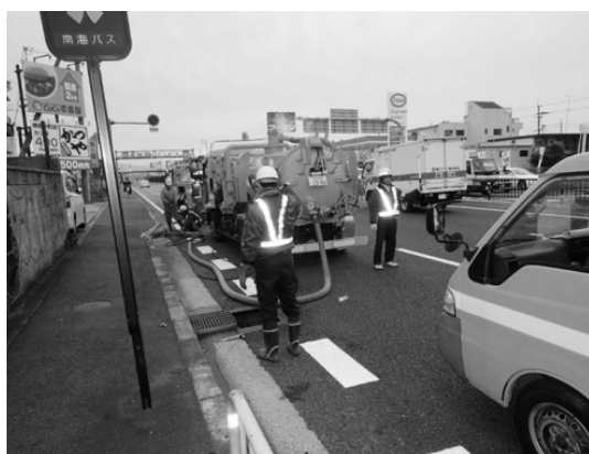
写真—12 管渠清掃作業状況
