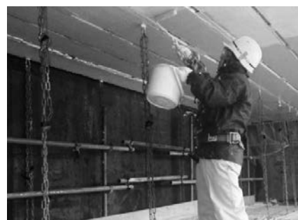
写真—7 仕上げ塗装状況
