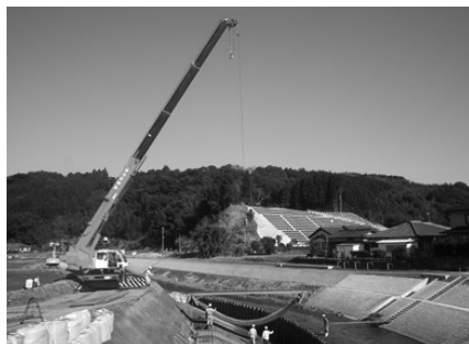
写真—4 ブロックマット設置状況
