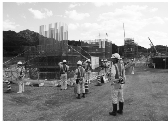
写真—3 現場点検
