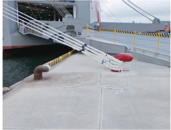
写真一 4 整備された係船柱（右） （左は既設の係船柱）
