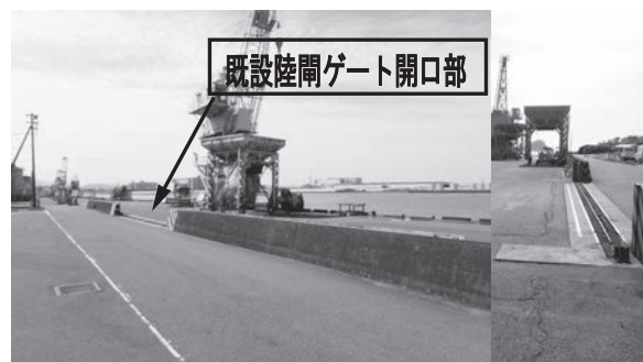
写真—5 既設陸閘（横引きゲート）
