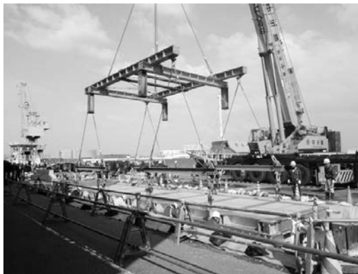
写真一 8 ゲート据付状況
