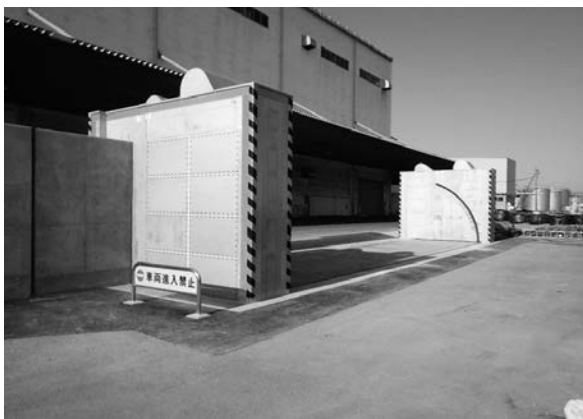
写真－1 施工完了状況（堤外側から）
