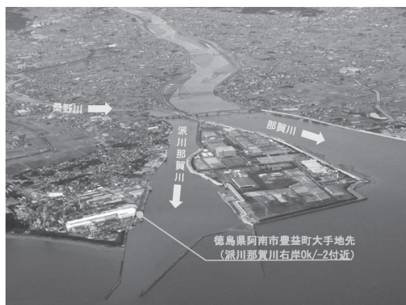
写真—4 施工箇所
