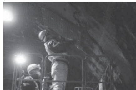
写真—3 A技術の施工状況
