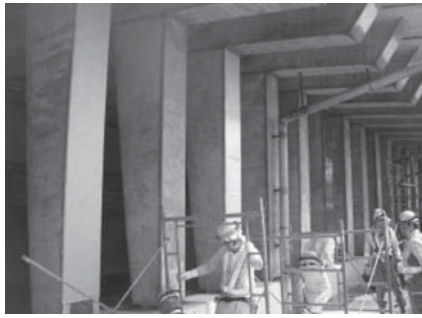
写真一六 ロックシェッドにおける試験施工
