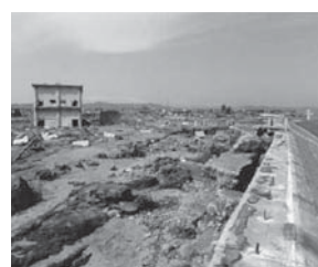
浸食・流出した阿武隈川右岸の堤防（宮城県巨理郡巨理町荒浜地先）
