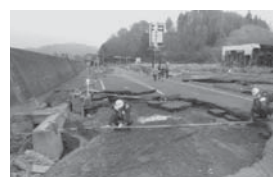
中部地方整備局TEC-FORCEによる被災状況調査 2011.3.14
