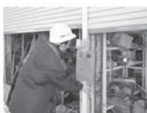
写真一 17 被災建築物の応急危険度判定
