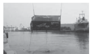
航路啓開状況・仙台塩釜港（沈んだコンテナの除去）
