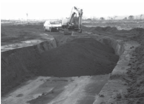
(a)サイクリングロード工事業 (宮城県名取市)
