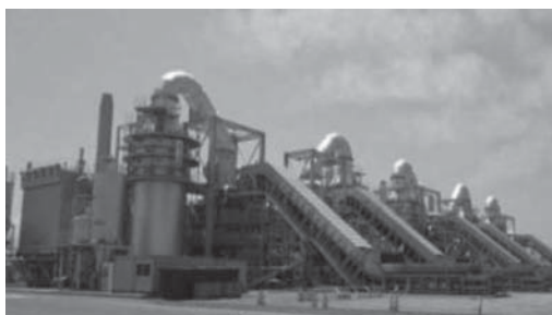
(a)仮設焼却炉（平成23年4月宮城県亘理町）
