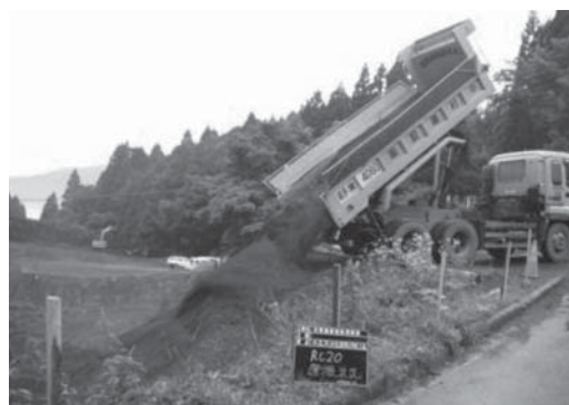
(b)大船渡綾里三陸線小石浜地区道路改良工事 (岩手県大船渡市)
