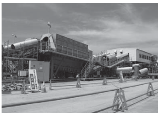
(e)仮設の破碎・選別処理施設 (平成25年6月宮城県南三陸町)
