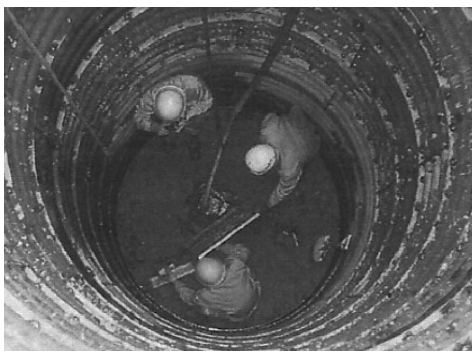
写真 1 ライナープレートによる土留工法
