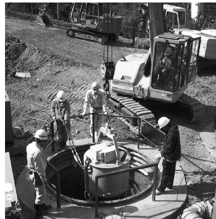
写真 3 遠心力吹付け工法施工写真
