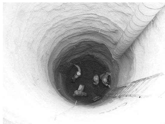
写真 5 施工完了写真
