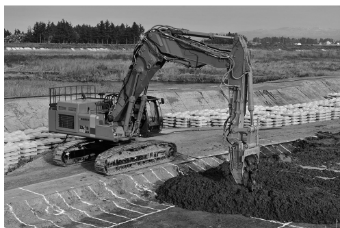
写真二 作業状況（スラリー噴射攪拌）
