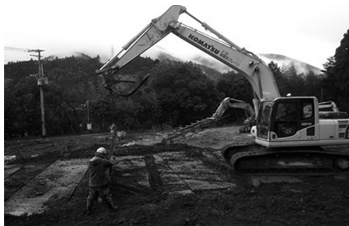
写真四 敷鉄板移設状況
