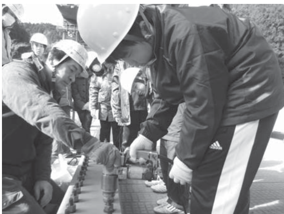
写真—2 小学生のボルト締め体験 （越川大橋補強工事）
