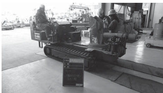
写真二 小型クローラークレーンの分解状況
