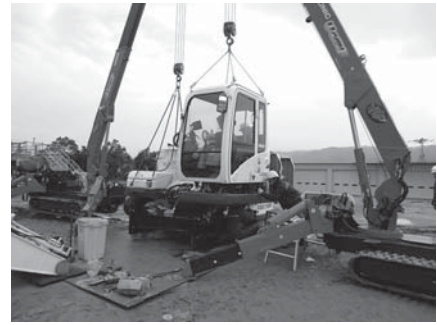
写真-5 分解組立型バックホウの組立状況(1)
