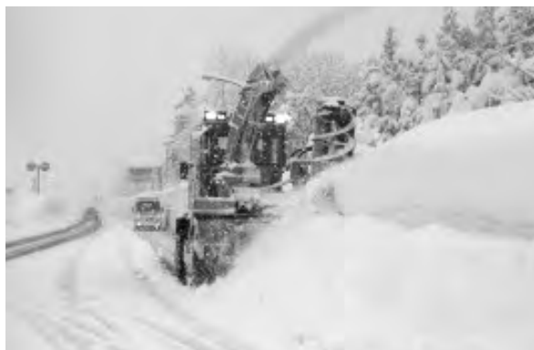
写真一 1 ロータリ除雪車による拡幅除雪状況
