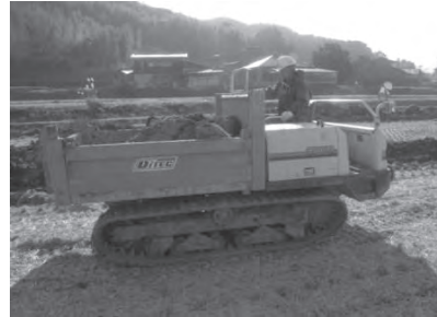
機械小運搬(不整地運搬車) 施工状況
