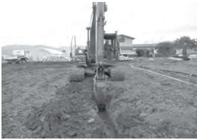
掘削(床掘) 施工状況
