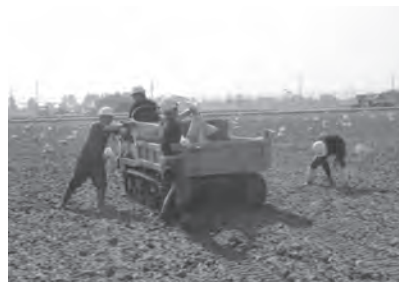
機械小運搬(不整地運搬車) 施工状況
