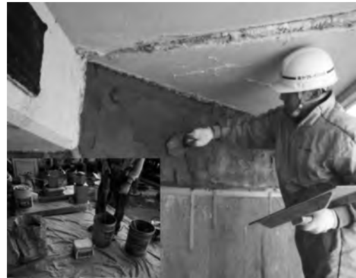
写真一 断面修復工（左官作業）
