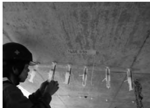
写真二 ひび割れ補修工
