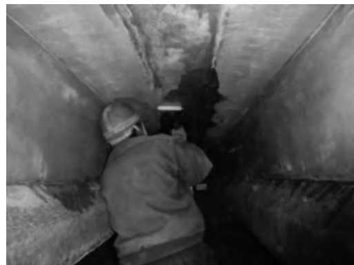
写真三 表面被覆工
