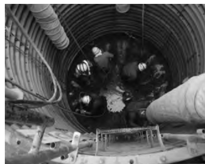
写真一六 人力施工状況
