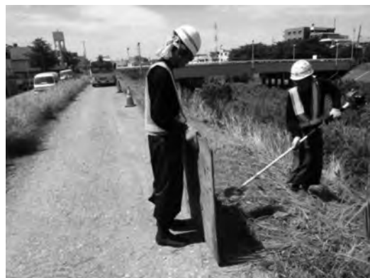
写真四 とび石防護（堤防除草工）
