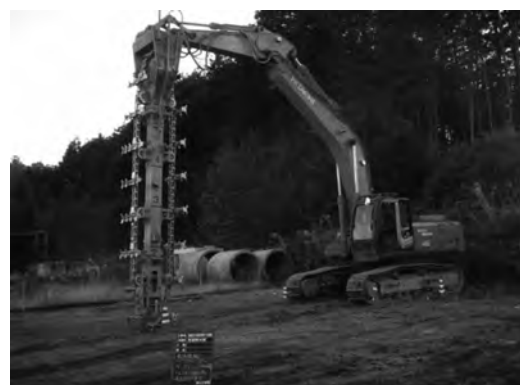
写真一五 中層混合処理機
