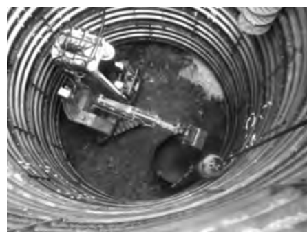
写真一七 機械施工状況
