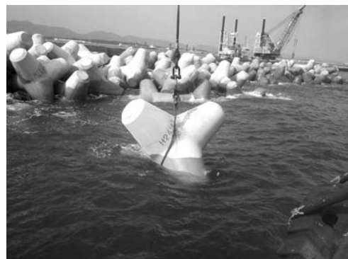
写真 12 消波ブロック設置状況
