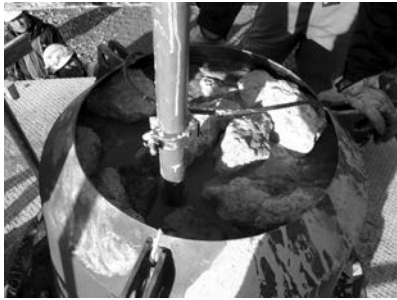
モルタル注入状況
