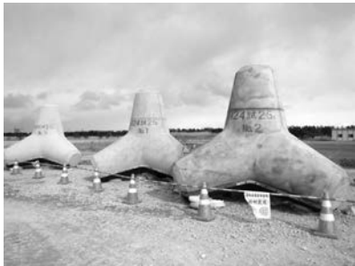
完成した消波ブロック
