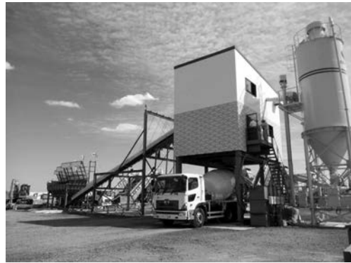
写真 5 製造プラント
