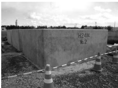
完成した根固めブロック
