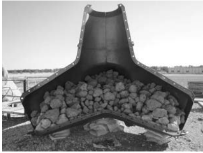
がら投入状況
