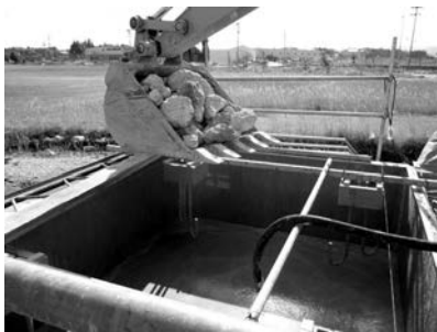
がら投入状況
