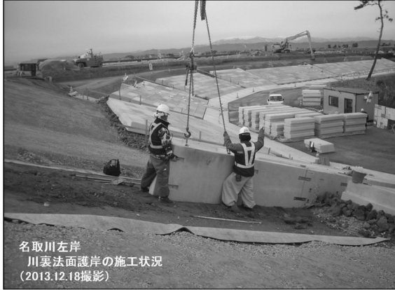
写真 2 直轄河川堤防復旧状況（名取川左岸地区）
