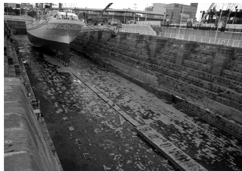
写真 4 扉船左側から渠頭部を見た一号ドック
