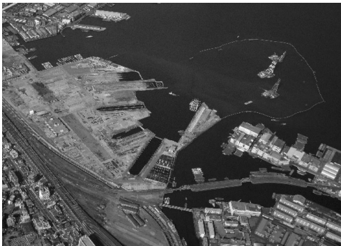
写真 1 みなとみらい21着工間もないころの旧横浜船渠のドック。一番大きいドックが第一号、その左が第二号、第三号
