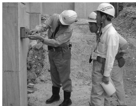
写真 2 施工直後の構造物の点検状況
