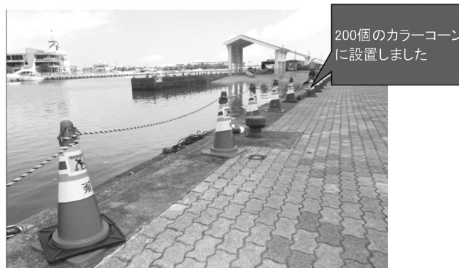
写真 6 転落防止設置完了
