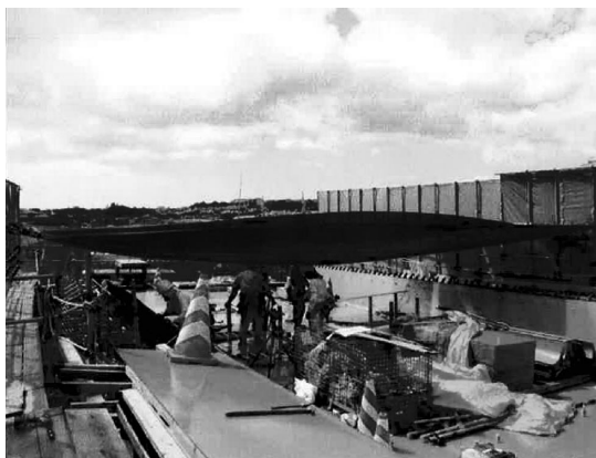
写真 1 施工時の避暑設備として遮光ネットの設置
