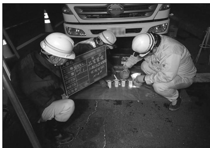
写真 2 下水道管更生工法（製管工法）における充填材の圧縮強度試験用供試体作成状況
