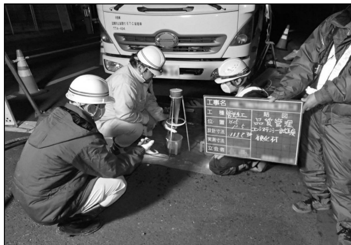
写真 1 下水道管更生工法（製管工法）における充填材のコンシステンシー試験硬化材試験状況
