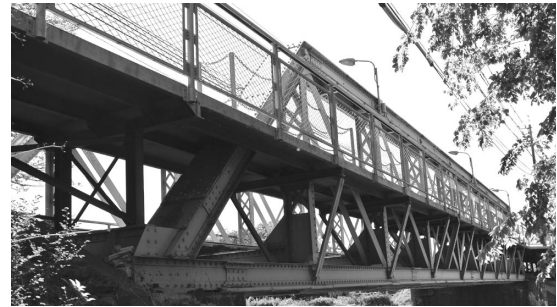
写真 3 下から見上げた石手川橋梁
