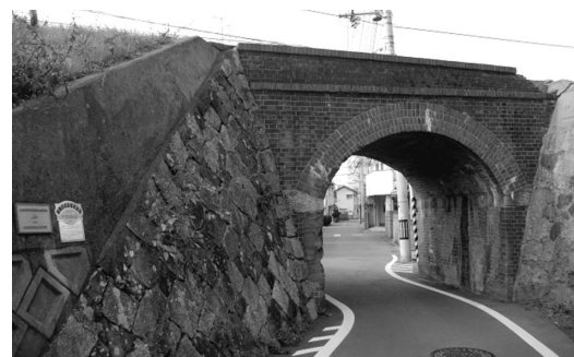
写真 4 選奨土木遺産のレンガ橋
