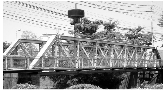
写真 2 国内最古の鋼鉄道橋
