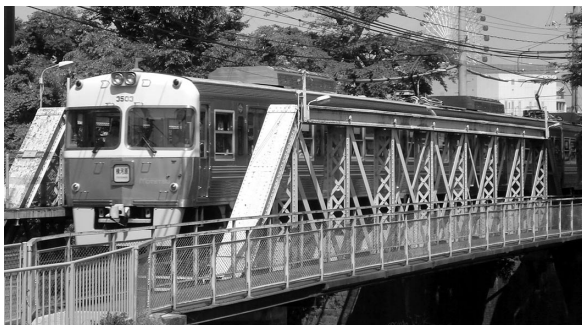
写真 1 石手川橋梁を通過する3000系電車
