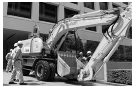
写真 8 道路復旧工事の重機調達訓練
