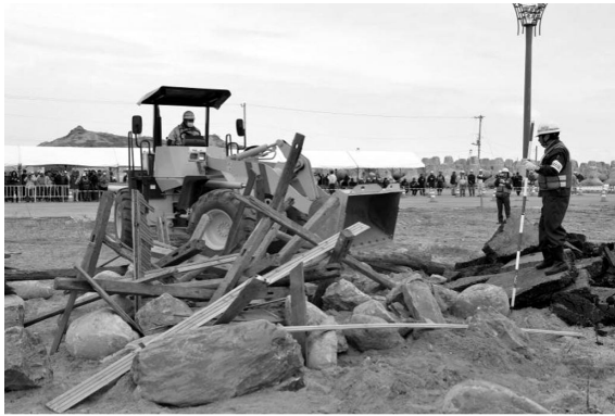
写真 8 道路啓開訓練の様相
