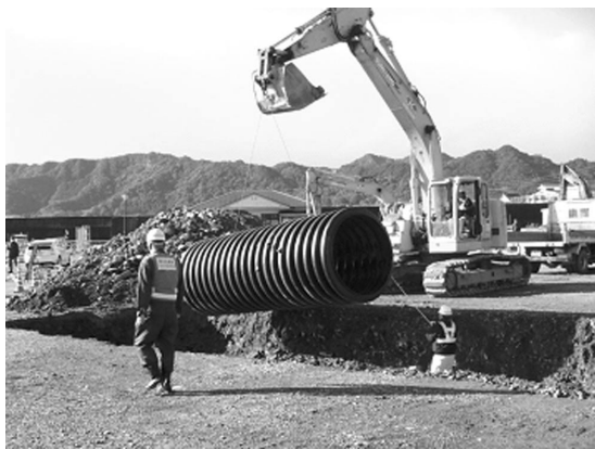
写真 5 近畿地方整備局と地元建設業協同組合による流出橋梁復旧訓練の様相
