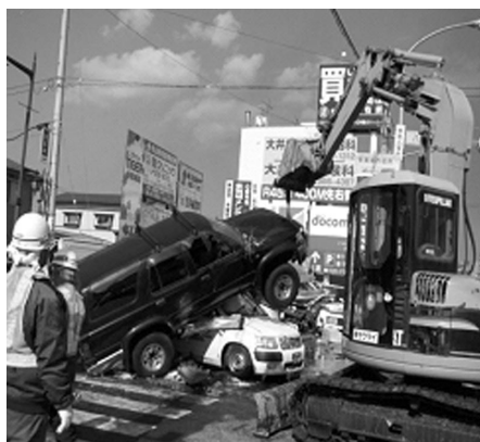
写真 2 国道45号道路啓開の状況 (宮城県多賀城市)
