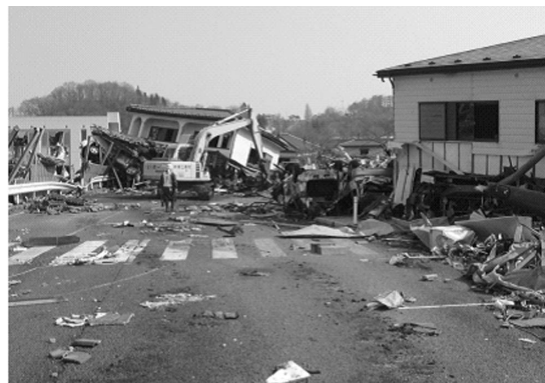
写真 1 国道45号道路啓開の状況（岩手県宮古市）
