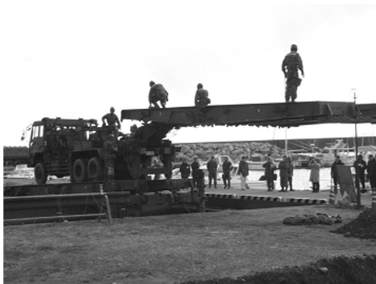
写真 6 陸上自衛隊による流出橋梁復旧訓練の様相
