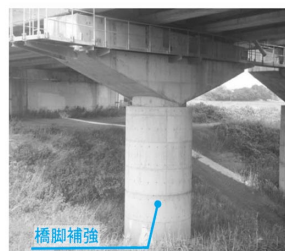
【耐震補強済み(RC巻立補強)】 地震動により損傷なし
