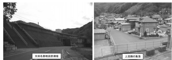
写真 2 太田名部地区防潮堤(岩手県下閉伊郡普代村)の事例
