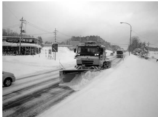
写真 2 除雪トラックによる除雪
