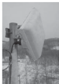
写真一六 アンテナへの雪付着による受信不良（資料提供：北海道開発局）
