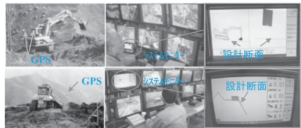
写真一〇 情報化施工導入システム (上段) 油圧ショベルガイダンス、 (下段) ブルドーザ排土板自動制御
