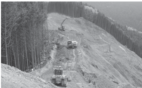
写真一〇 北股地区無人化施工状況
