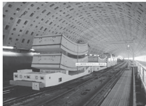
写真-5 セグメント自動搬送システム（清水建設）
