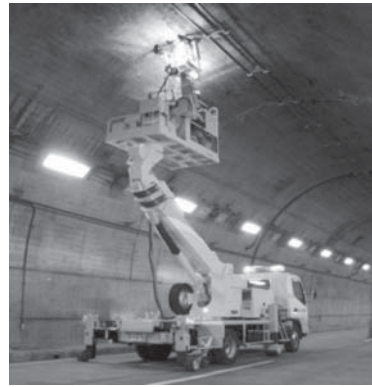
写真一2 トンネル覆工打音点検システム
