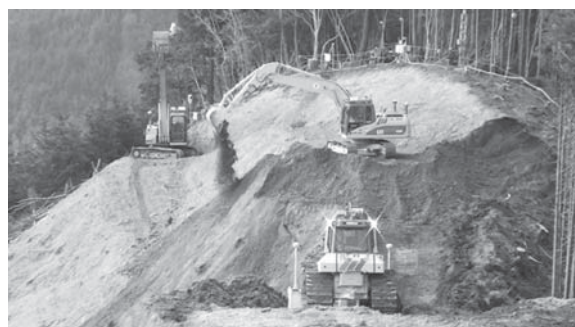
写真一 奈良県北股地区での災害復旧対策工事
