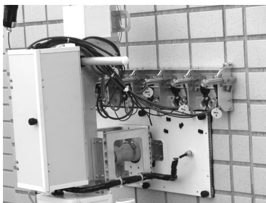
写真 2 打音装置の取り付け状況
