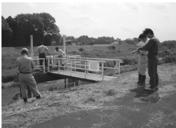
写真 4 許可工作物（樋門）
