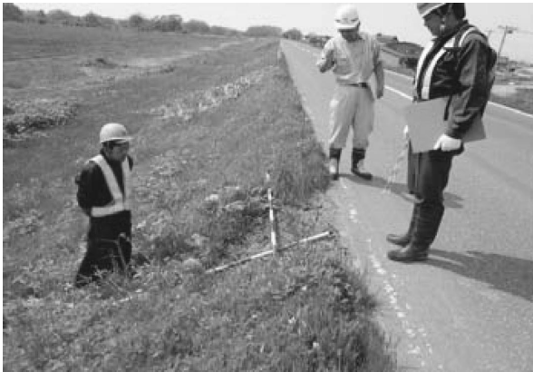
写真 1 堤防の点検
