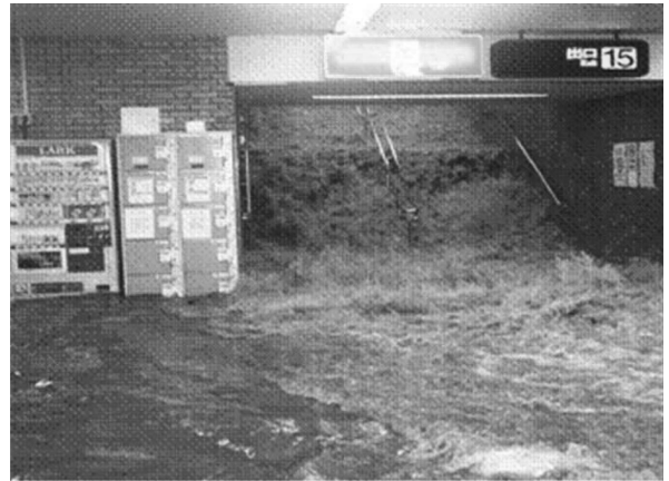
写真 6 地下街の浸水
