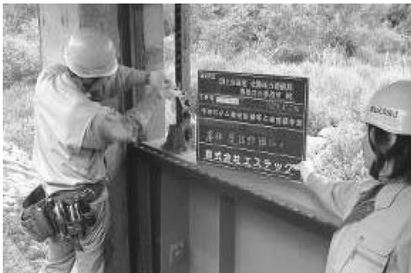
写真 2 樋門ゲートの点検
