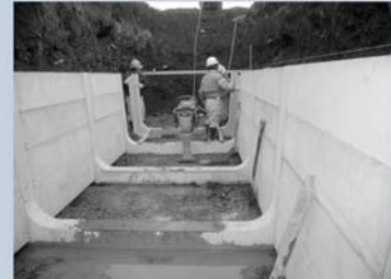
底版簡易整正状況
