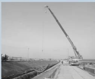
ブロックマット布設状況
