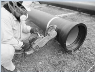
グラインダによる切断状況
