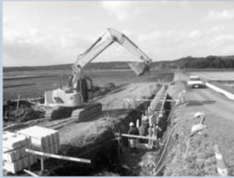
アーム据付状況
