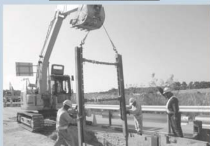
たて込み状況
