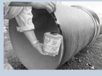
切断後の塗装状況
