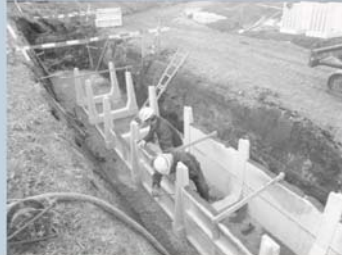
パネル設置状況
