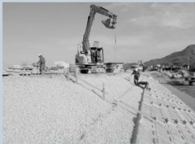
ブロック吊り込み状況
