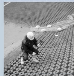
アンカー設置状況
