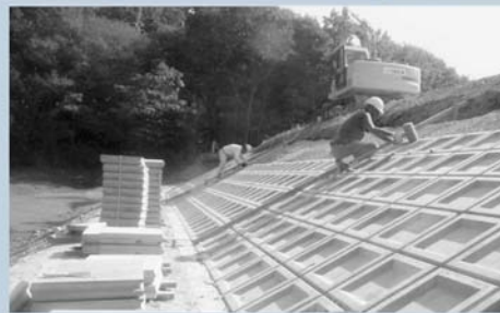
ブロック設置状況
