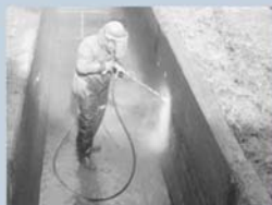
高圧洗浄状況
