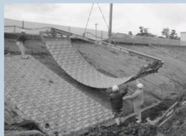
ブロックマット布設状況
