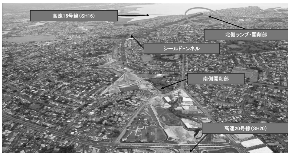
図 5 現場現況（2012年12月，WellConnected Alliance提供）
