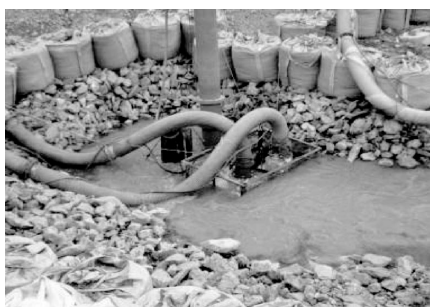
写真－１ 水中ポンプでの排水状況
