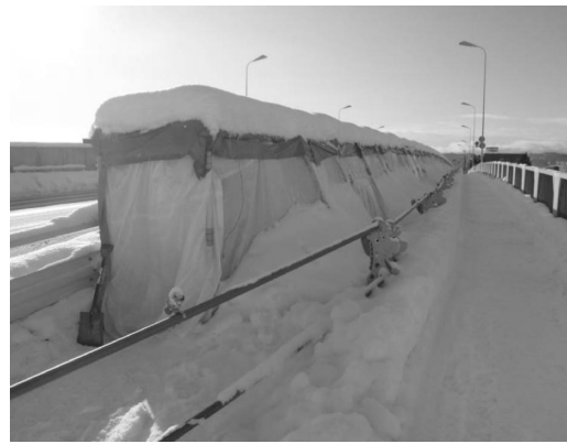
写真 3 防寒仮囲い状況
