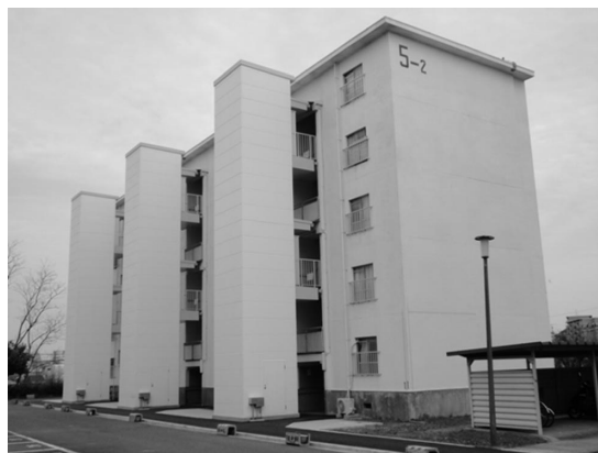
写真 1 ひかりが丘住宅エレベーター設置後 外観写真
