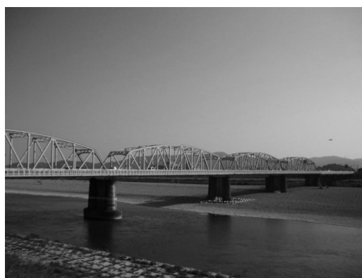
写真 1 那賀川橋（一般国道55号：徳島県）
