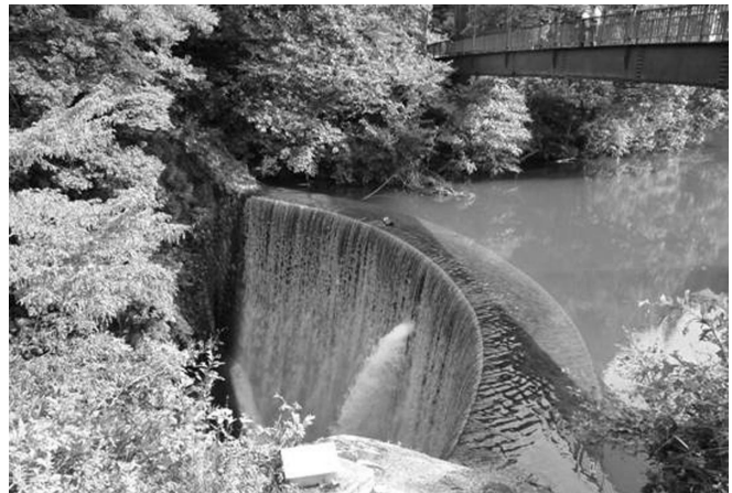
写真 1 大源太川第1号砂防堰堤全景
