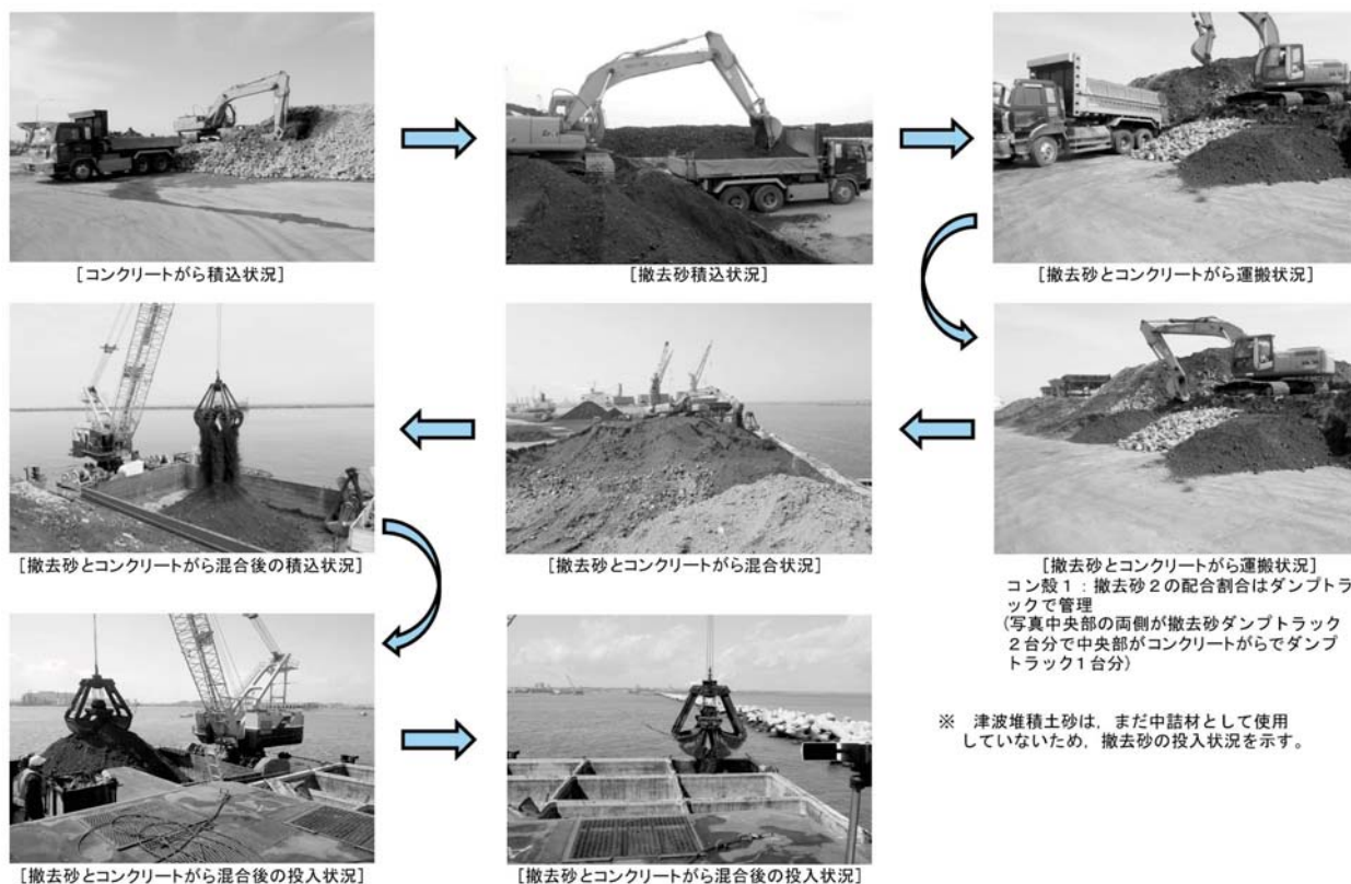
写真—5 津波堆積土砂活用手順（イメージ図）
