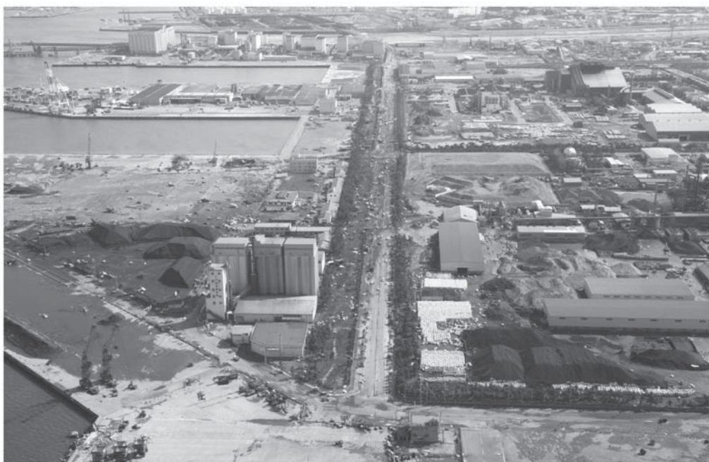
写真一 津波による土砂堆積状況
