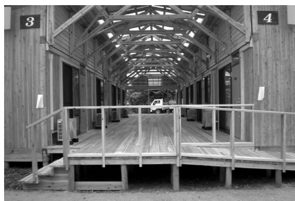
写真 1 事例：玄関を向かい合わせにし、バリアフリー化のためのデッキを設置している（岩手県遠野市）
