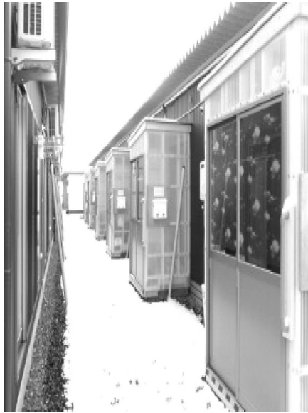
写真 2 事例：風除室の設置（宮城県石巻市）
