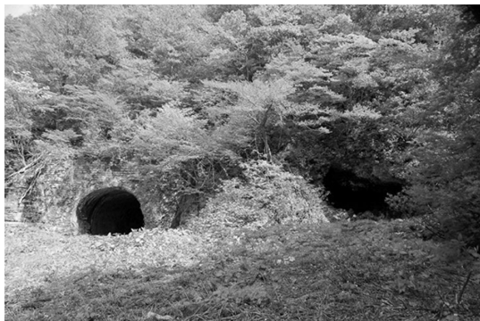
写真—4 明治坑口（右）と昭和坑口（左）
