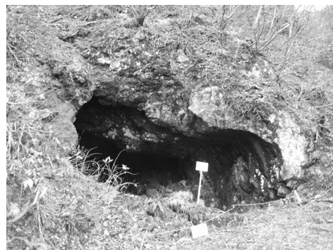
写真—1 栗子山隧道米沢側坑口 （平成23年11月撮影）
