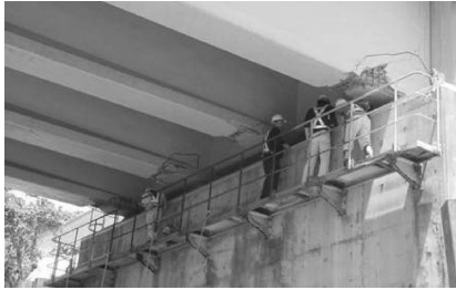
写真 1 検査路による 近接点検
