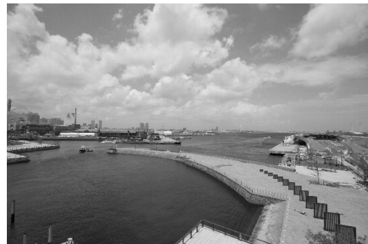
写真 4 象の鼻防波堤全景
