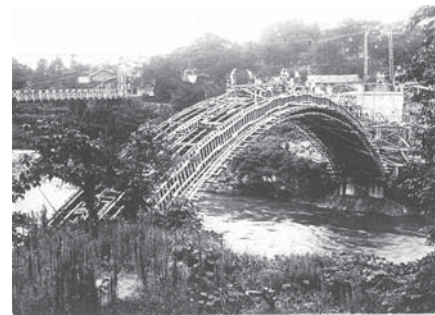
写真—2 施工中の笹津橋，アーチ部分の形が見えてきたところ
