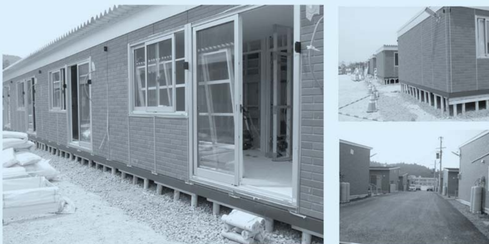
写真一 2 応急仮設住宅の事例②—ハウスメーカーが建設する例—
