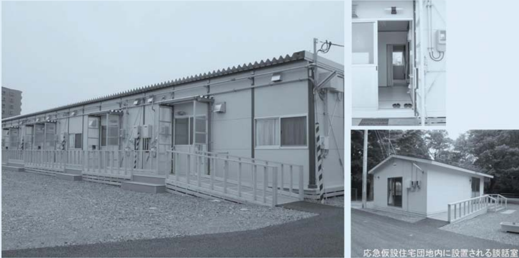
写真一 1 応急仮設住宅の事例①—プレハブメーカーが建設する例—
