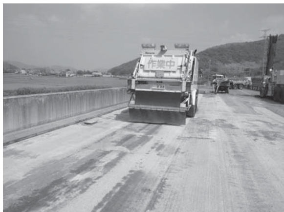
写真一2 切削後の清掃作業
