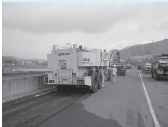
写真-1 舗装路面の切削・廃材積込作業
