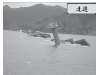
写真一1 防波堤の被災例（釜石港 湾口防波堤）
